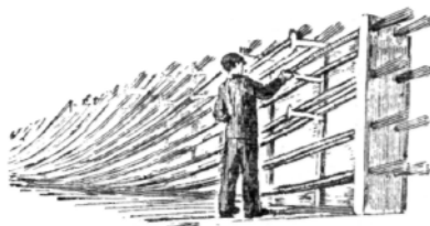
Монтаж пучков проволоки железобетонной балки моста перед бетонированием.
